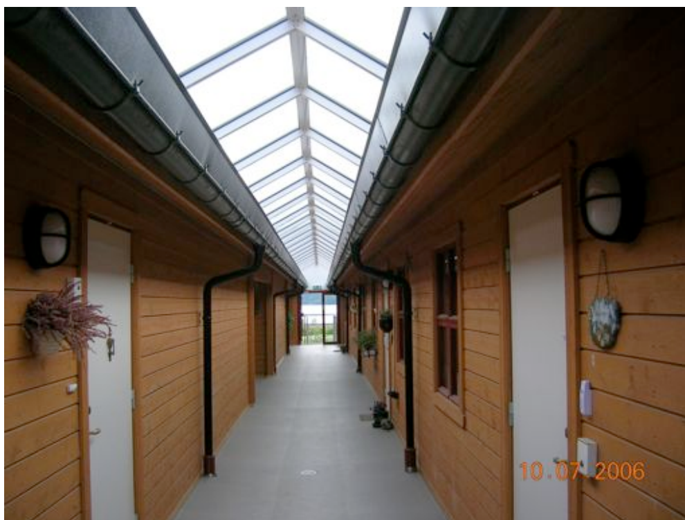
Bilde 5.7.1 a Rømningsveg i blokk C (overdekket korridor).
