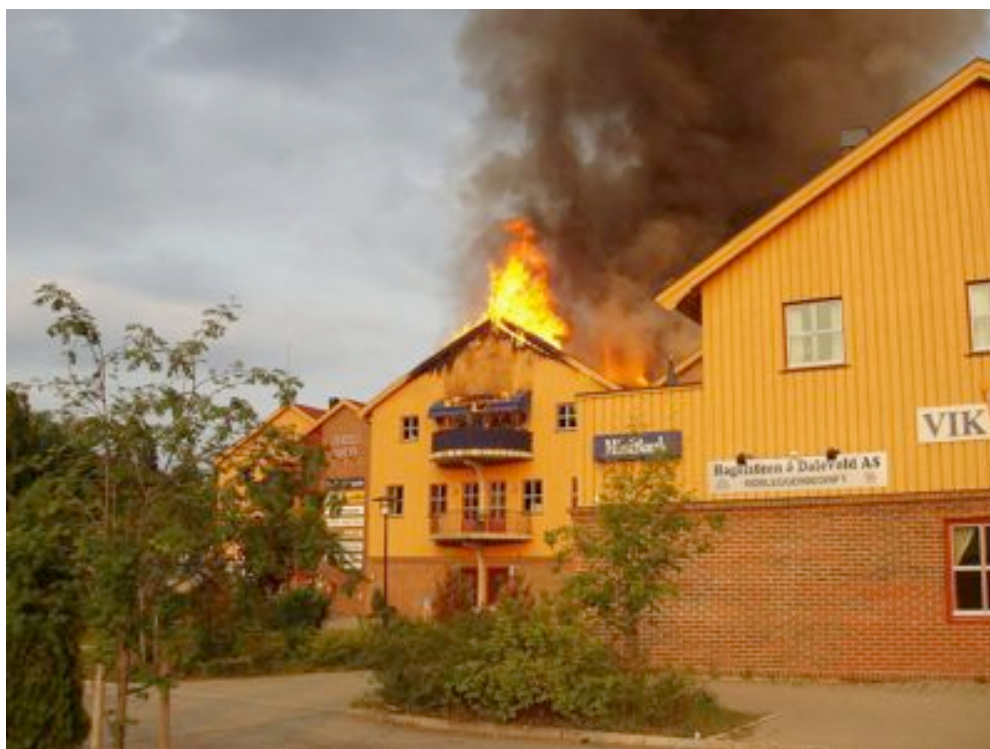
Bilde 4.2.2: Kl. 05:28, dvs. ca. ½ time etter at brannen slo gjennom taket. Hele loftet/taket brenner. Brennende materialer faller ned på markise/balkong på gavl mot syd i blokk B. Foto: Ole Raymond Lehne.
