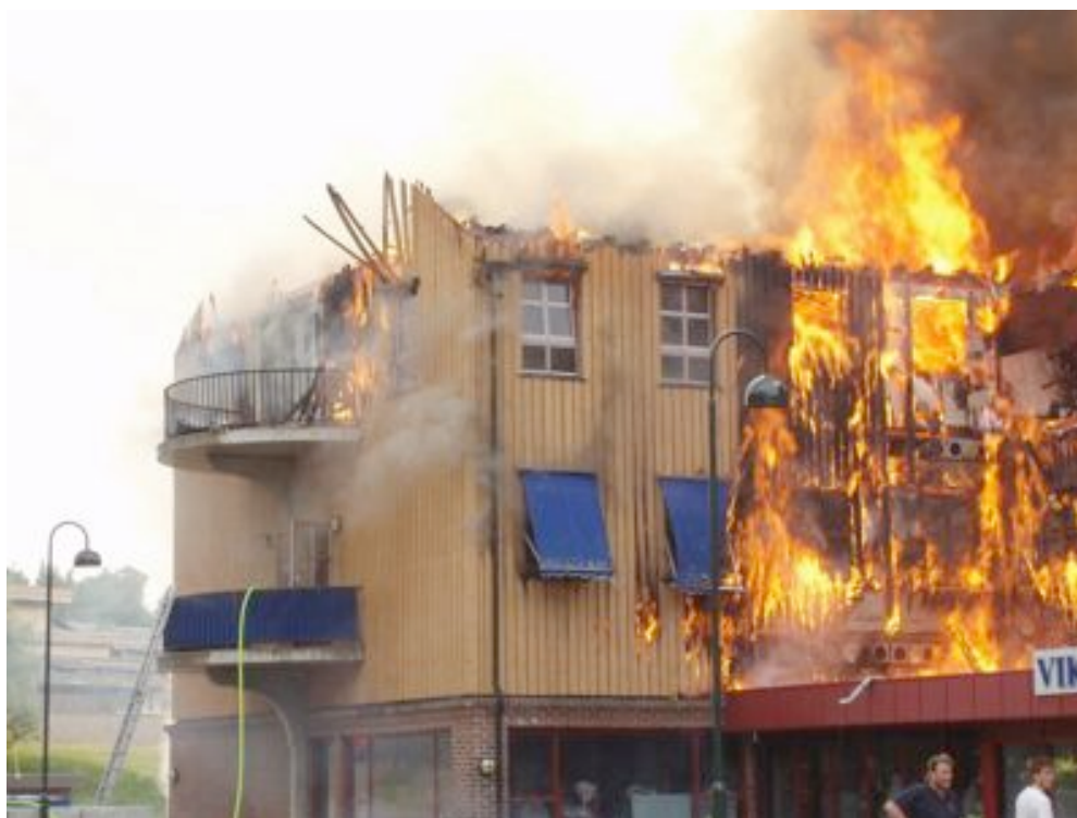
Bilde 4.2.3: Kl. 06:09. Blokk B, gavl mot syd og langvegg mot øst, ca. 1 time etter at brannen slo gjennom taket. Taket er borte. Store deler av langveggen brenner. Det brenner i isolasjonen innenfor ytterkledningen. Foto: Ole Raymond Lehne.
