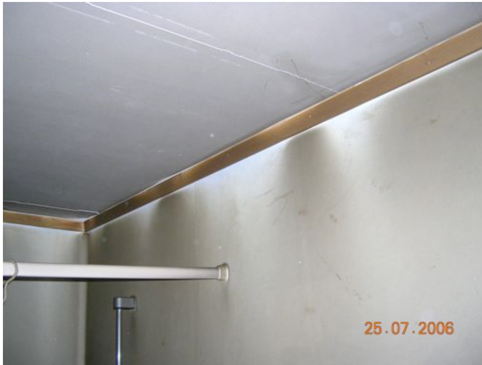
Bilde 5.1.2 a Sverting øverst på vegg hvor branngasser er presset nedover fra loftet.
