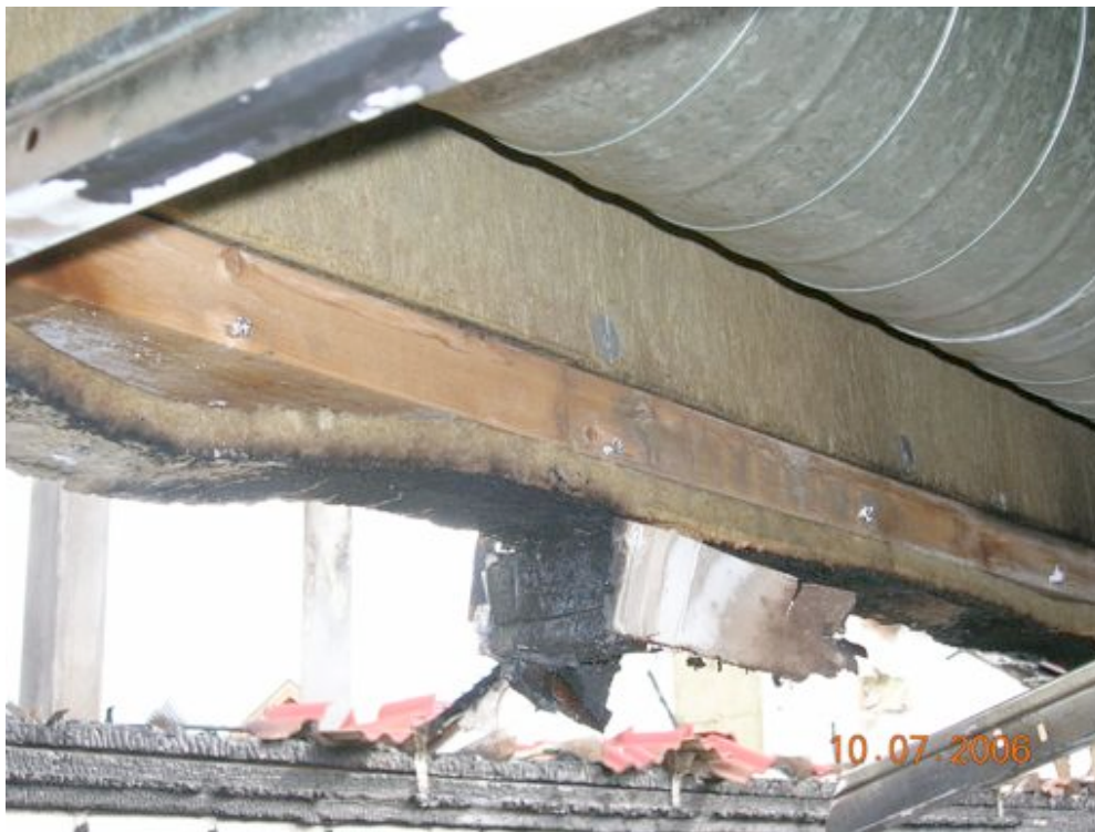
Bilde 5.1.2 m Brannpåkjent søyle i yttervegg blokk B, akse Y 11.
