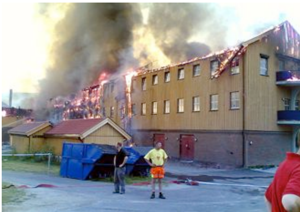
Bilde 5.1.2 c: Brennende deler av raft/takfot faller ned. Foto: Christian Grønsleth.
