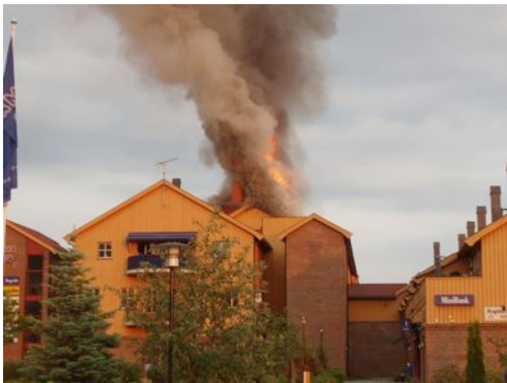
Bilde 4.2.1: Kl. 04:56. Flammene har nettopp gått gjennom taket i blokk B. Foto: Ole Raymond Lehne.
