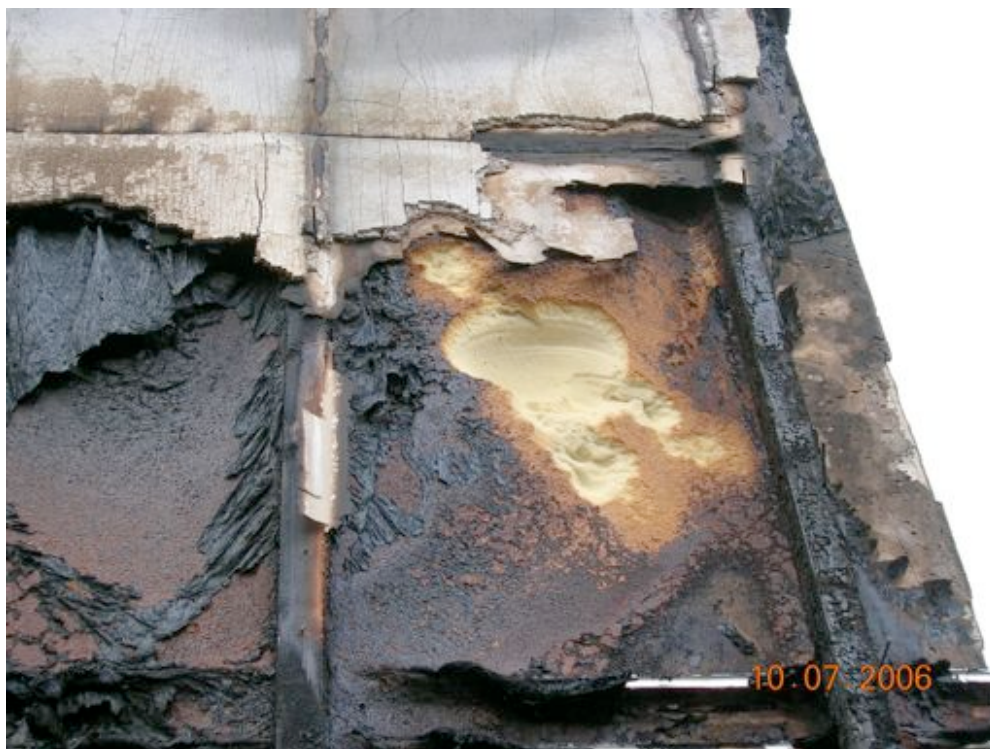
Bilde 5.1.2 g Brennbar isolasjon i fasaden
