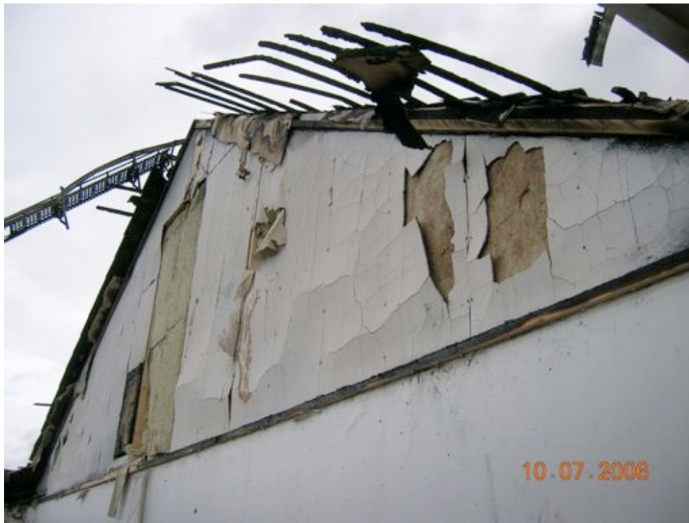
Bilde 5.1.2 n Brannskille i blokk C hvor brannen ble stoppet.
