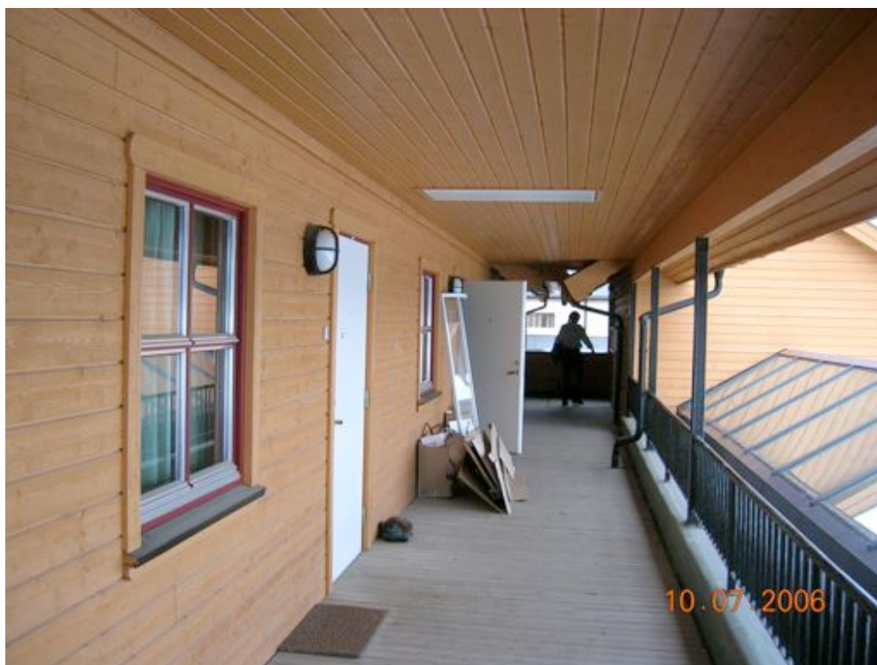
Bilde 5.7.1 a Rømningsveg i blokk A (svalgang).
