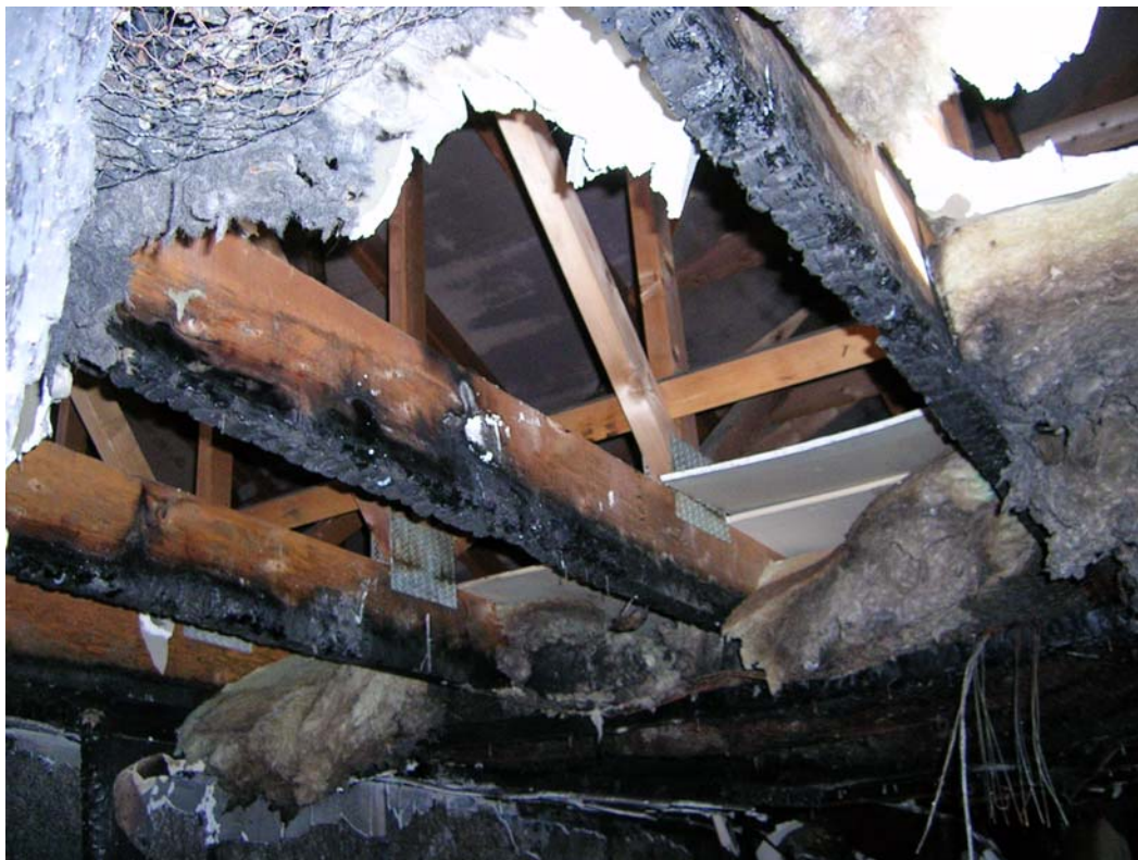
Bilde 9. Etasjeskiller mot loft – fra startbrannrommet (lintøyrommet).
