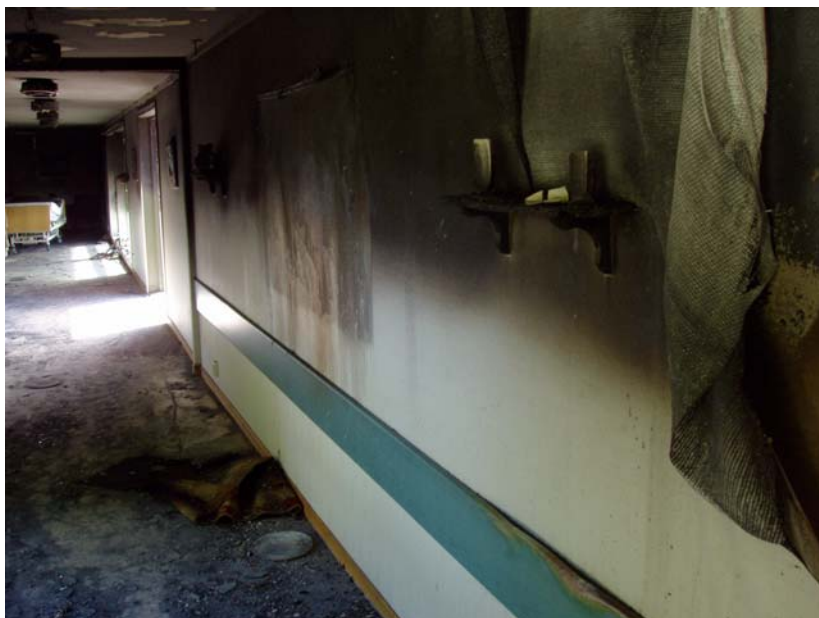
Bilde 5. Brannen har fritt spredt seg i korridoren mot bygning B, Solbakken.
