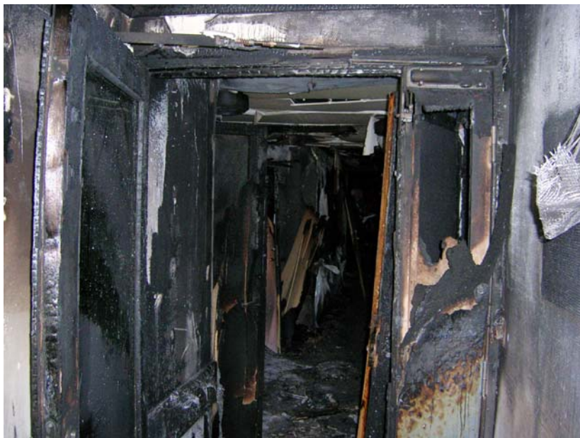
Bilde 4. Brannen har fritt passert den brannklassifiserte døren fordi den var holdt åpen med trekile.
