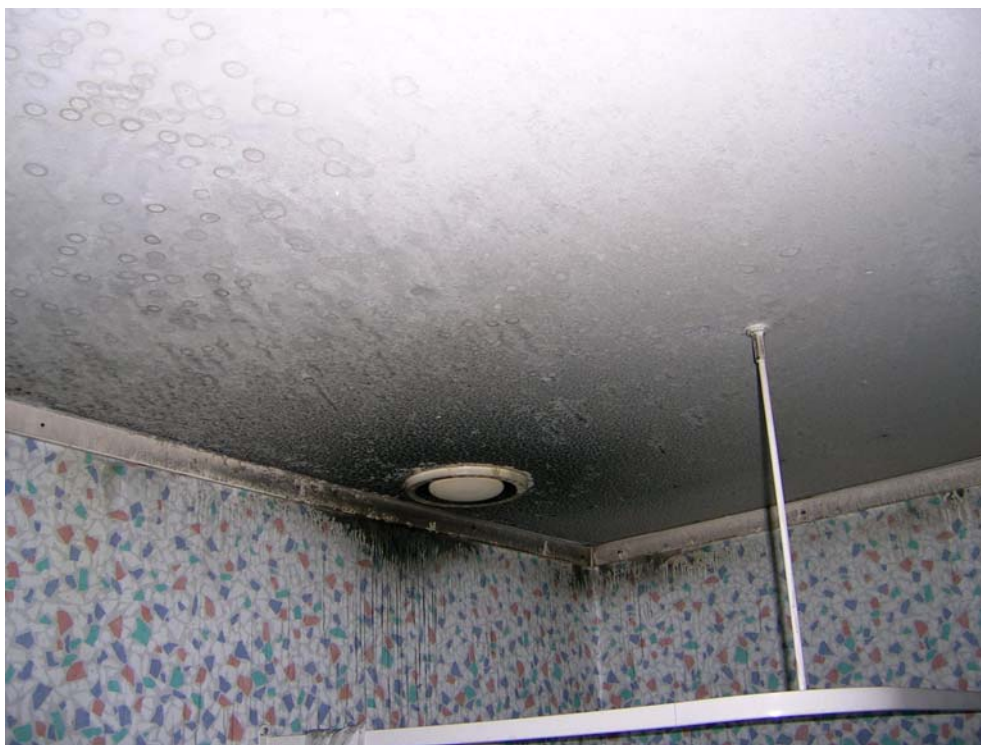
Bilde 12. Spor etter røykinntrengning slik den var på de fleste rommene.
