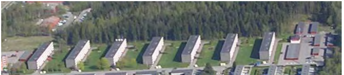
Bilde 2.1: Myhrerenga borettslag med 168 leiligheter blir sannsynligvis Nordens første rehabilitering med passivbyggkomponenter.
