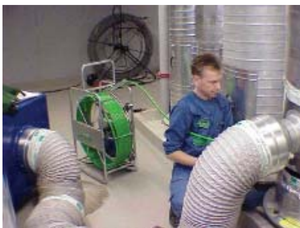
Rengjøring med roterende børste med motordrift via en vaier. Et kraftig sugeaggregat samler opp smuss via en fleksibel kanal. Foto: Lifa Air Ltd. Finland
