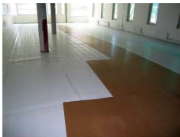
Ferdig lagte golv tildekkes med plastbelagt kraftpapir, og i tillegg bør det benyttes plater i transportsoner. Foto: SINTEF Byggforsk
