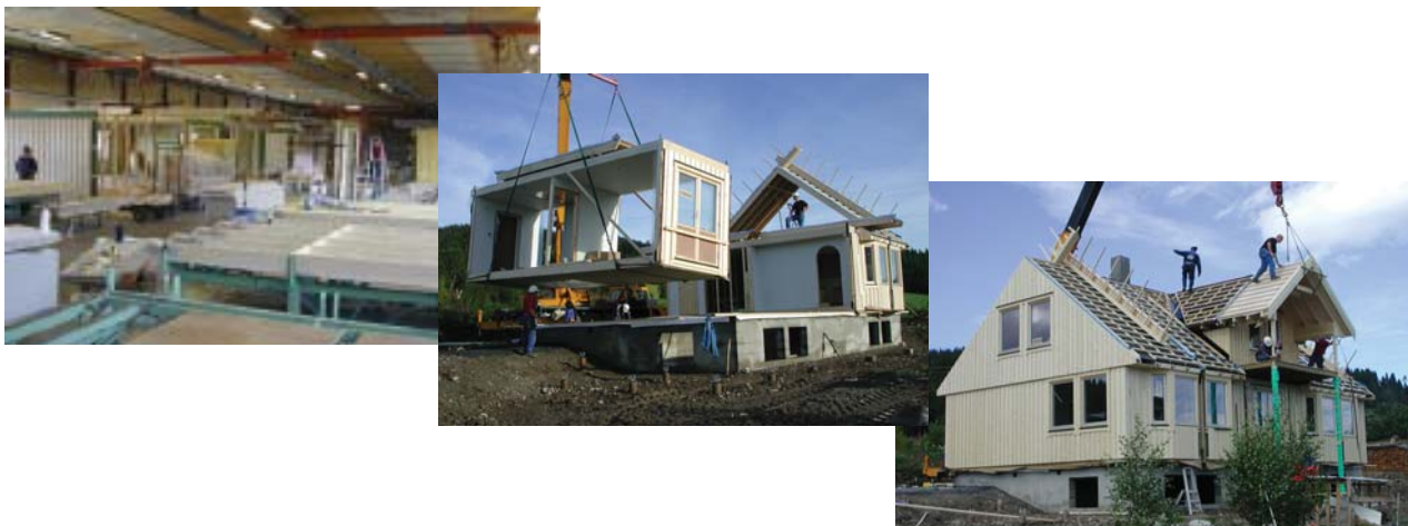
Eksempel på hvordan Selbuhus prefabrikerer en enebolig, og med sin spesielle takkonstruksjon raskt får et tett bygg. Foto: Selbuhus
