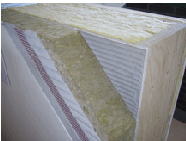
Figur 8.3: tverrsnitt av modell for ytterveggen
