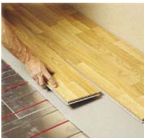
Figur 4.25 Elektriske varmekabler i tregulv [1]
