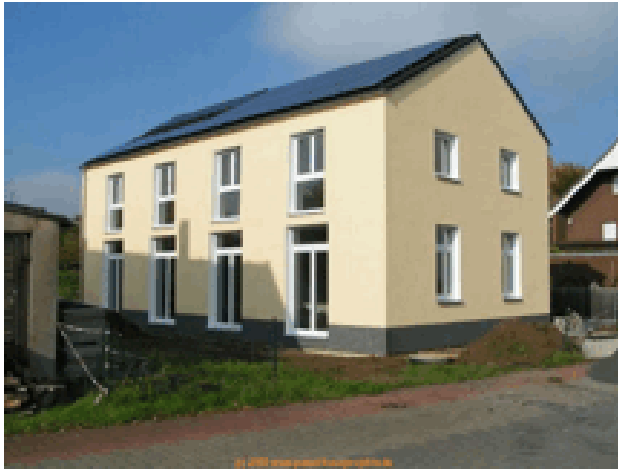
Figur 8.11: Eksterioret med solfangere på taket
