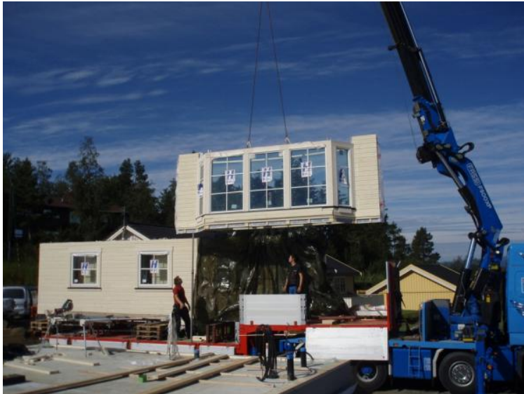
Figur 3.1 Montering av veggmoduler (Moelven)
