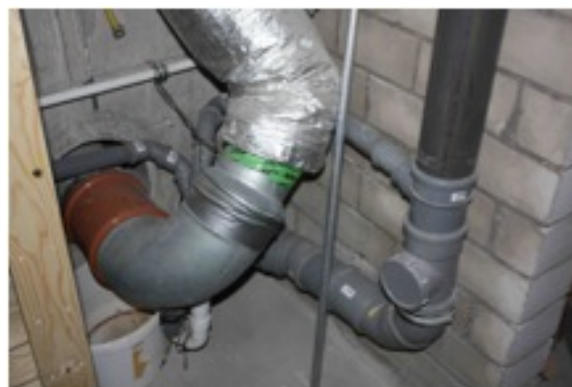
Figur 8.25: Ventilasjonsluft fra kulverten inn i huset. [3]
