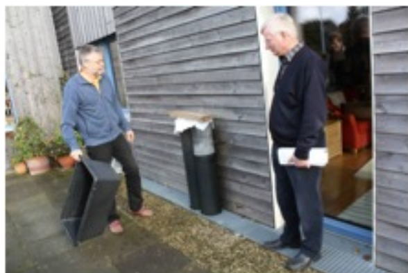
Figur 8.24: Luftinntak til kulverten under huset for å temperere ventilasjonsluften (ikke helt ferdig enda). [3]
