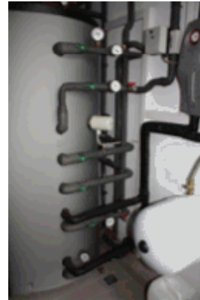
Figur 8.12: Kombiberederen for tappevann og oppvarming
