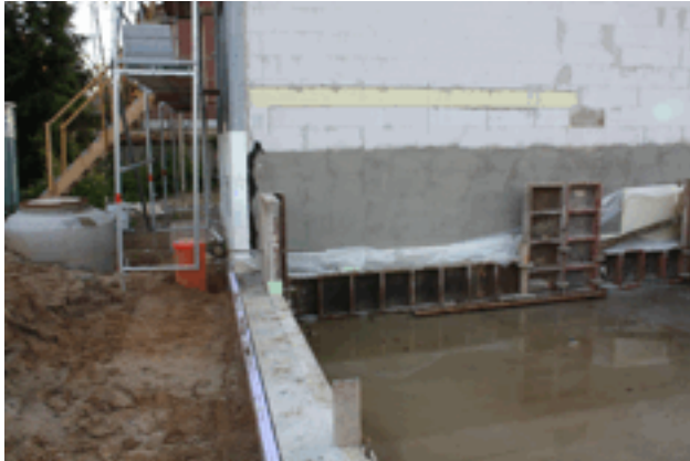
Figur 8.19: veggen av Ytong kledd med Neopor
