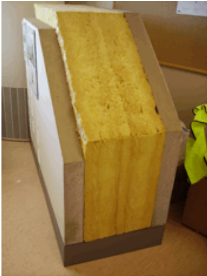
Figur 8.6: tverrsnitt gjennom veggen bygd i betong-sandwich-elementer
