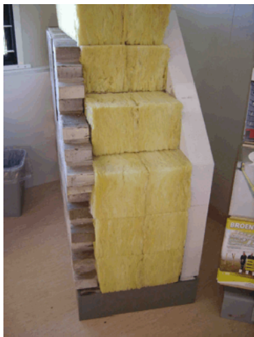
Figur 8.2: modell av ytterveggen
