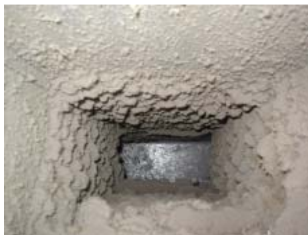
Tilsmusset avtrekkskanal. Foto: Danduct
