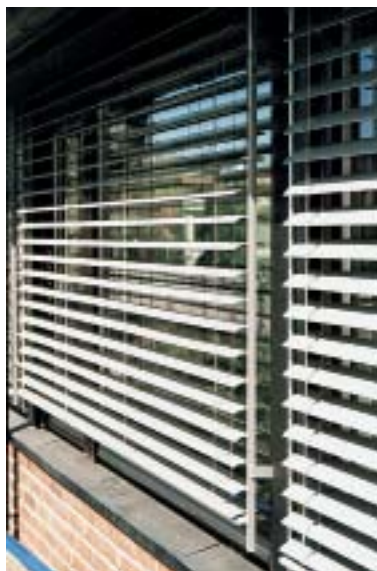
Utvendige, horisontale persienner med dreibare lameller. Foto: Norges solskjermingsforbund
