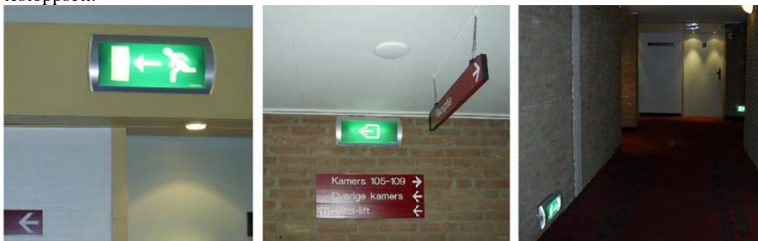
Figur 4-1: Eksempel på testoppsett hvor monteringshøyde for elektriske markeringsskilt undersøkes [36]. Gjengitt med tillatelse fra Copyright Clearance
