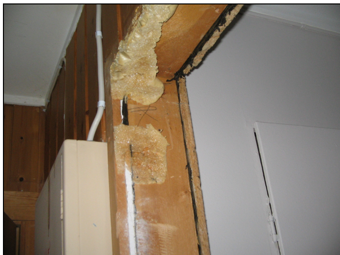
Figur 8: Fugeskum rundt dør
