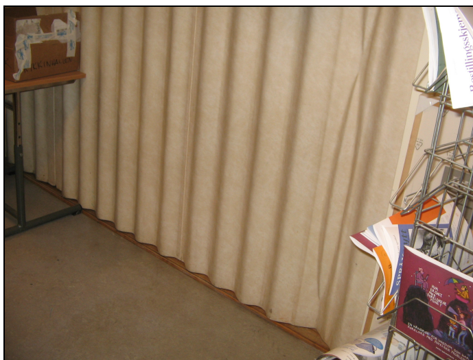
Figur 26: Foldevegg av PVC med DEHP-innhold på 21000 mg/kg
