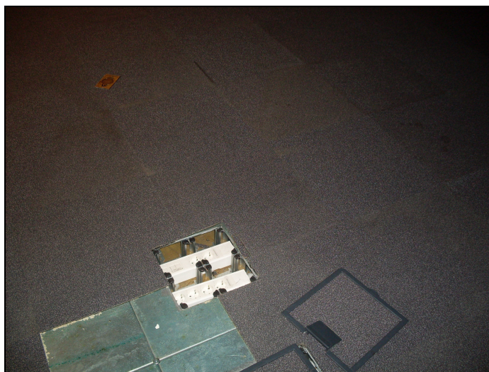
Figur 14: Teppe i kontorlokale. Her som teppefliser på datagulv.
