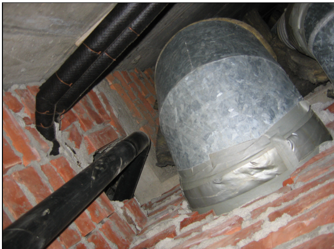
Figur 34: Teglstein, her som vegger i teknisk sjakt
