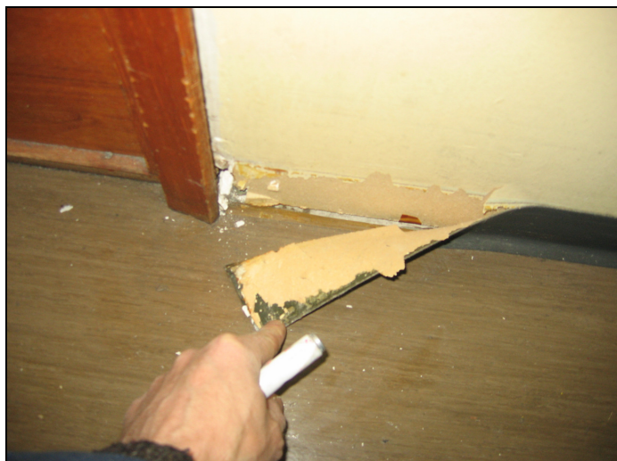
Figur 13: Mørkegrå gulvlist av PVC. Listen er limt til veggen.
