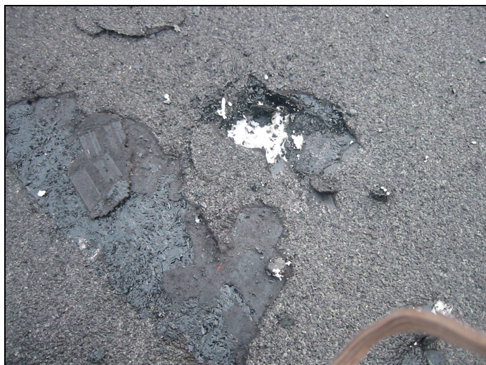
Figur 1: Den største forekomsten av EPS-plater i norske bygninger finnes trolig på flate tak, under asfaltpapp
