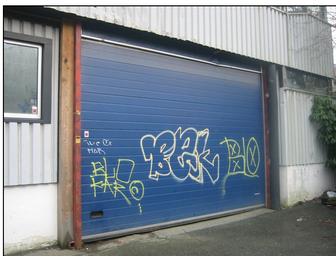
Figur 5: Garasjeport isolert med stivt polyuretanskum
