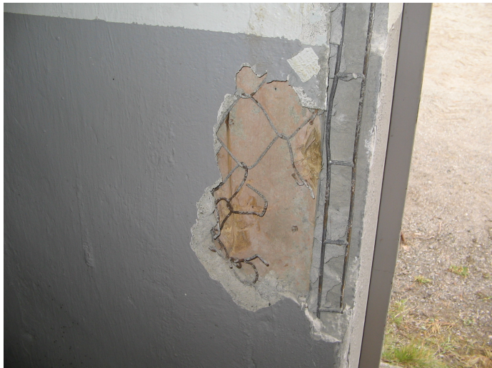
Figur 30: Murpuss med maling på
