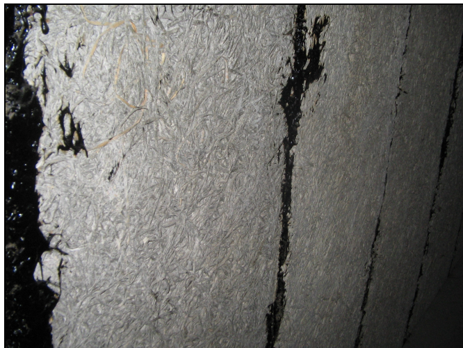
Figur 19: Lim (mellom treullsementplater)
