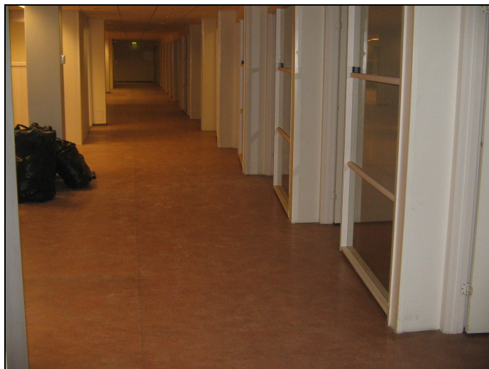
Figur 11: Linoleumsbelegg på gulv i kontorlokale
