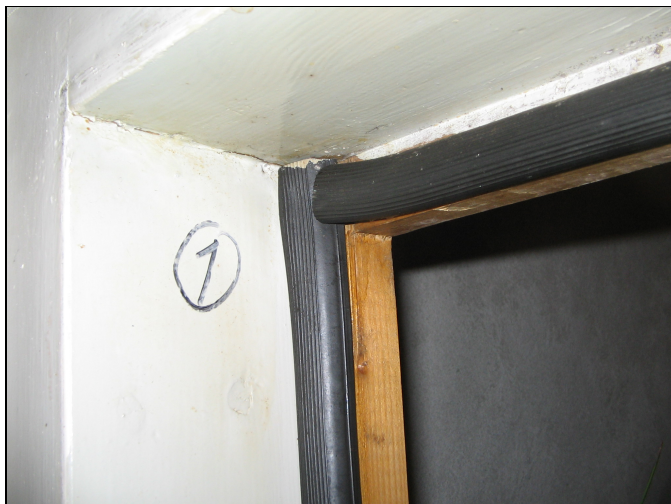
Figur 23: Gummilist som tettelist rundt dør til kjølerom
