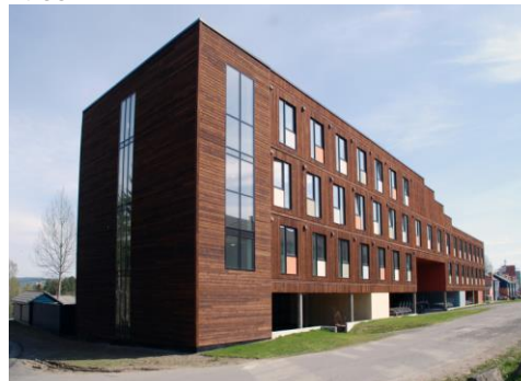
Boligkompleks på Kallerud, Moelven ByggModul
